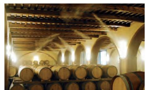
**Cosa migliora con Perfect Cool?** Potrete portare l'umidità della vostra cantina fino al 90%. Le goccioline d'acqua (circa 10micron) evaporano immediatamente riducendo al minimo l'effetto bagnato. L'elevato tasso di umidità così ottenuto garantisce una minore evaporazione del vino all'interno delle botti e ridotti interventi di colmatatura.
